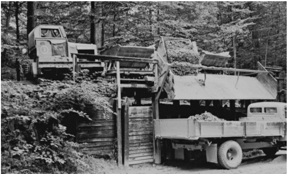
Læsseramper ved Stumpedysevej, hvor leret blev væltet fra tipvognene ned på lastbilerne, der kørte det til teglværkerne. (Foto: Erik V. Petersen) 1958.
