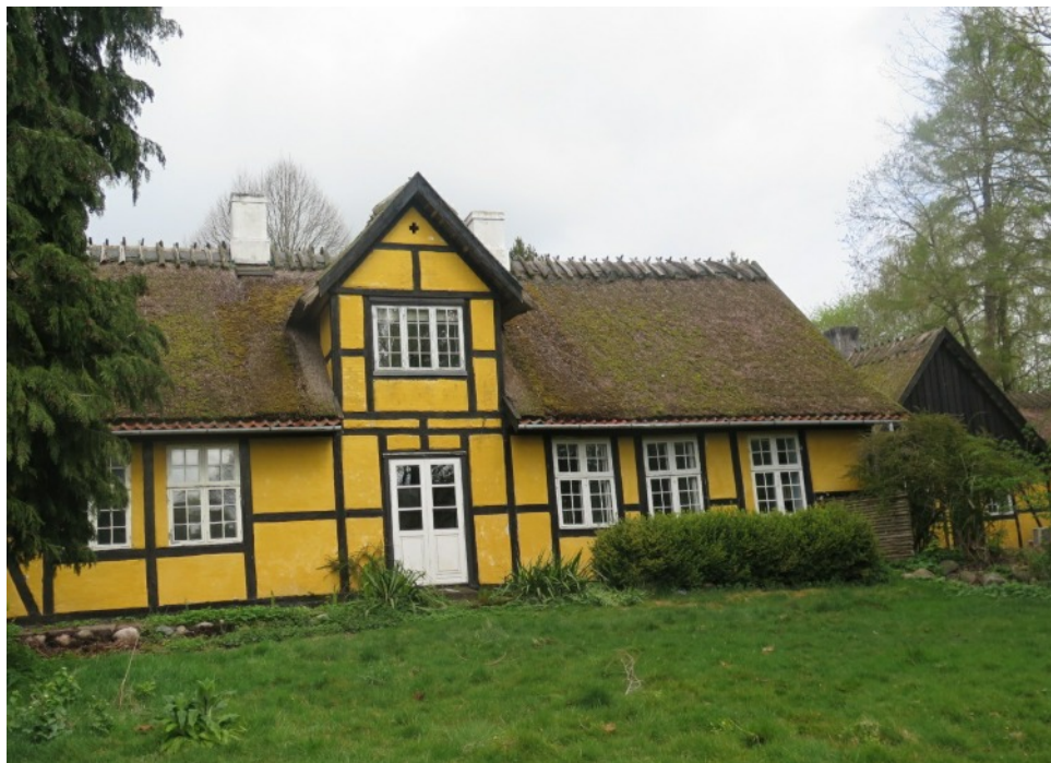
Dæmpegaards hovedbygningens sydfacade.
