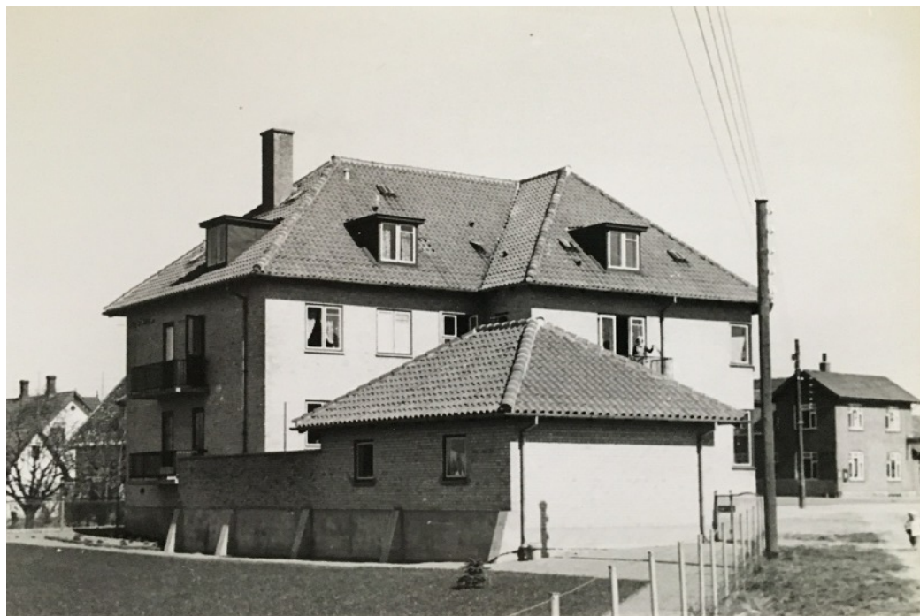
Bagsiden af bankbygningen med et kig ad Femvej til Lillerød Bageri (til højre) Yderst til venstre ses Frederiksborgvej 29, og villaen, der blev nedrevet for at give plads til Jyske Banks 'nye' filialbygning.
