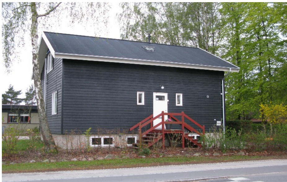
Arkivet blev indrettet med brandsikre stålskabe i 'Finnehuset' på Frederiksborgvej 59 i 1986.
