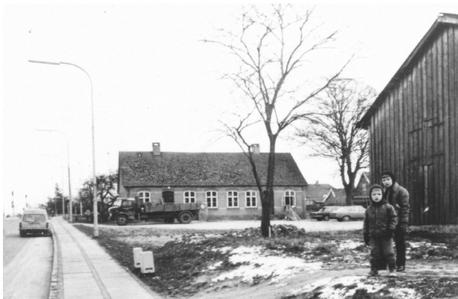
Lynghøjgård delvis under nedrivning. I baggrunden anes 'Femvejskrydset'. 1975.
