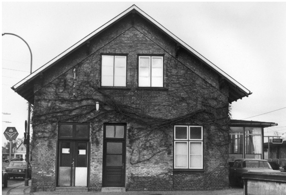
Stationsbygningens sydgavl med dør til postkontoret. Ca. 1980.
