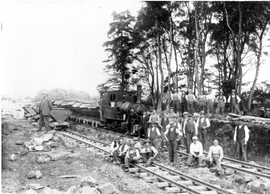
Udgravningerne til viadukt og nedkørsler foregik med håndkraft og tipvogne. Billedet fra 1933 må være fra Tokkekøb Hegns sydligste hjørne ved nuværende Banevang. Man kan tælle 29 mand, deriblandt to i 'jernbaneuniform' og herren til venstre uden arbejdstøj er nok en overordnet.
