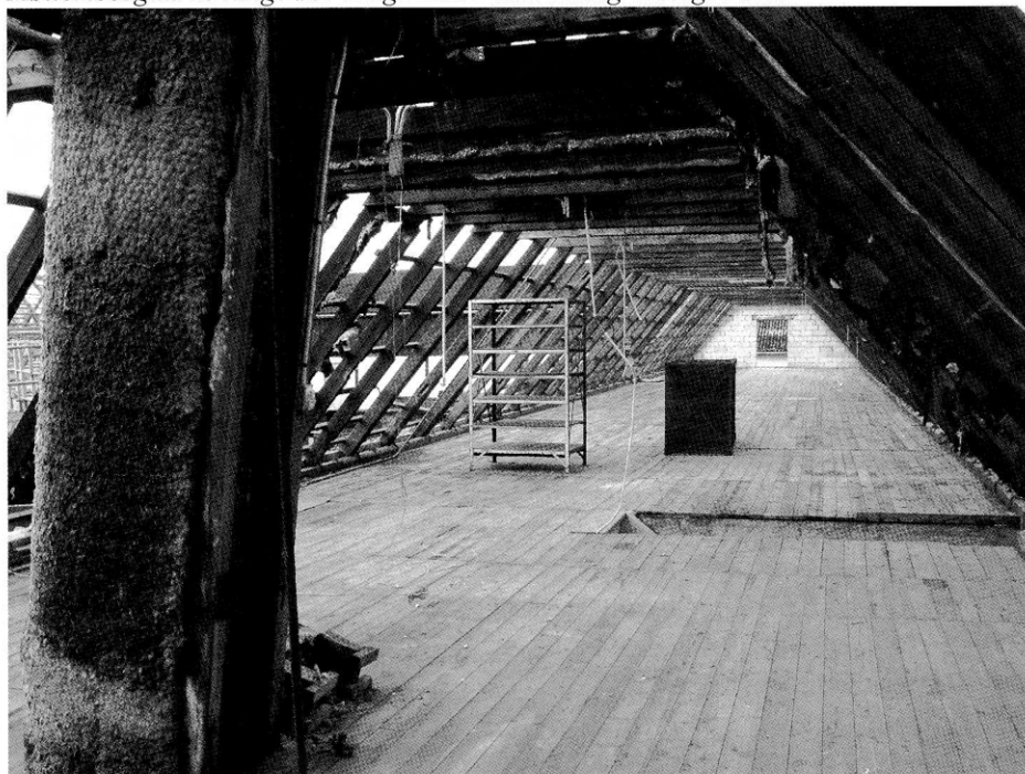
Møllemosegaards lange øst-længe under nedrivning 3. Aug. 2012.
