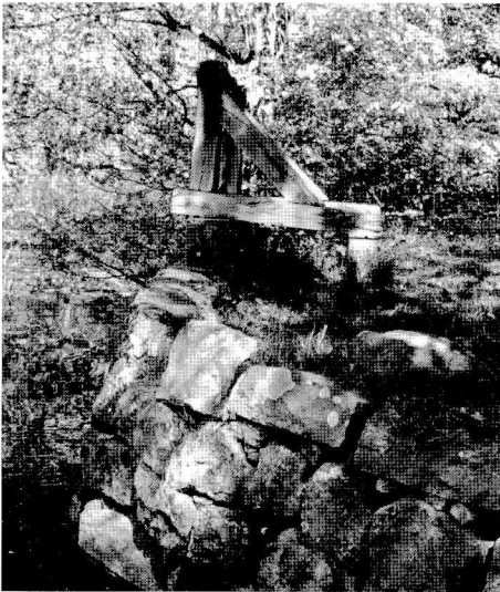
Slusen med den markante stigningskonstruktion i egetømmer, monteret på denstensatte dæmning.
