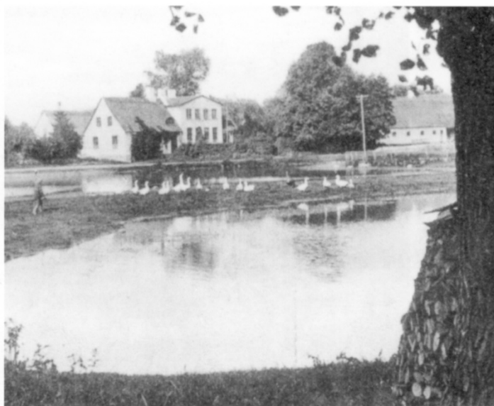
Bloustrød Skole må have været den samme, men stærkt ombyggede skolebygning.
