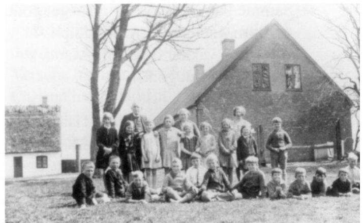
Vassingerød Skole (1931) på Gl. Vassingerødvej blev helt ombygget i 1915.
