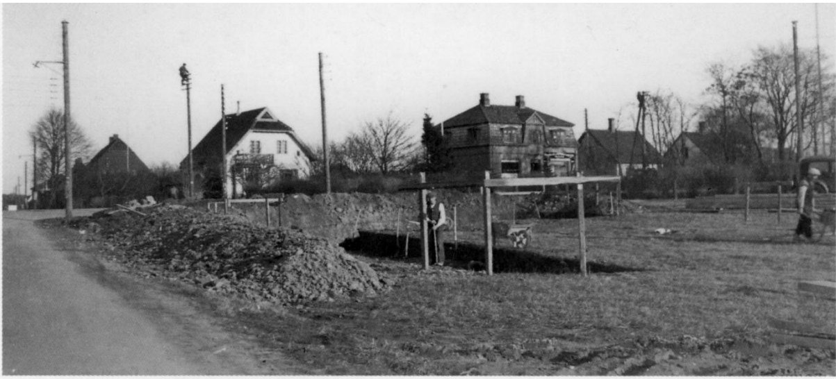
Grunden til den nye Landbobank-bygning på hjørnet af Kollerødvej og Frederiksborgvej håndgraves i 1935. Bagved ses den tidligere bankbygning.
