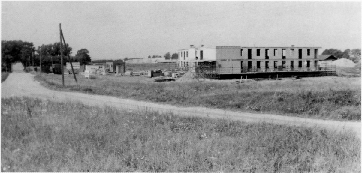
Den gamle Kollerødvej og rådhusbyggepladsen, september 1973.
