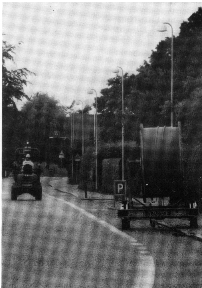
De enkle og pæne nye lysmaster kom op på Frederiksborgvej og andre steder i 2007, men der arbejdes stadig med den store opgave på andre veje.
