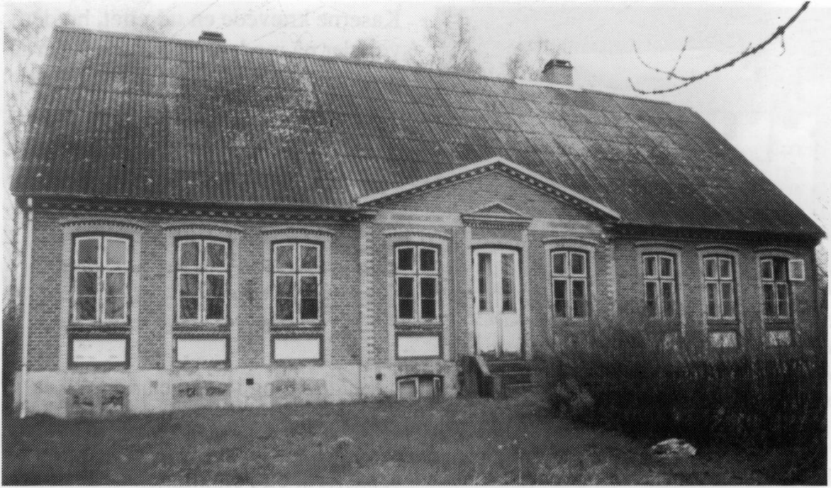
Stuehuset fra Tornagergaard på Kettingevej står nu ubenyttet, og det haster hvis den fine gård, der engang var Blovstrøds sognefogedbolig, skal reddes. Under pladetaget ligger i øvrigt et intakt stråtag.
