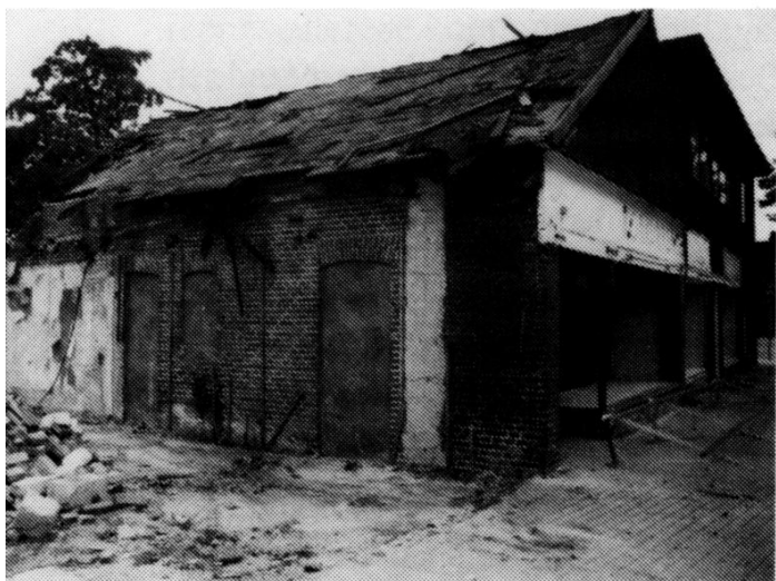
Da bygningen, der husede „Konkurrenten“ (tidligere isenkram mv) blev skrællet, dukkede facaden mod passagen (Skjold Burne mm) op, og viste tilmurede døre og vinduer.
