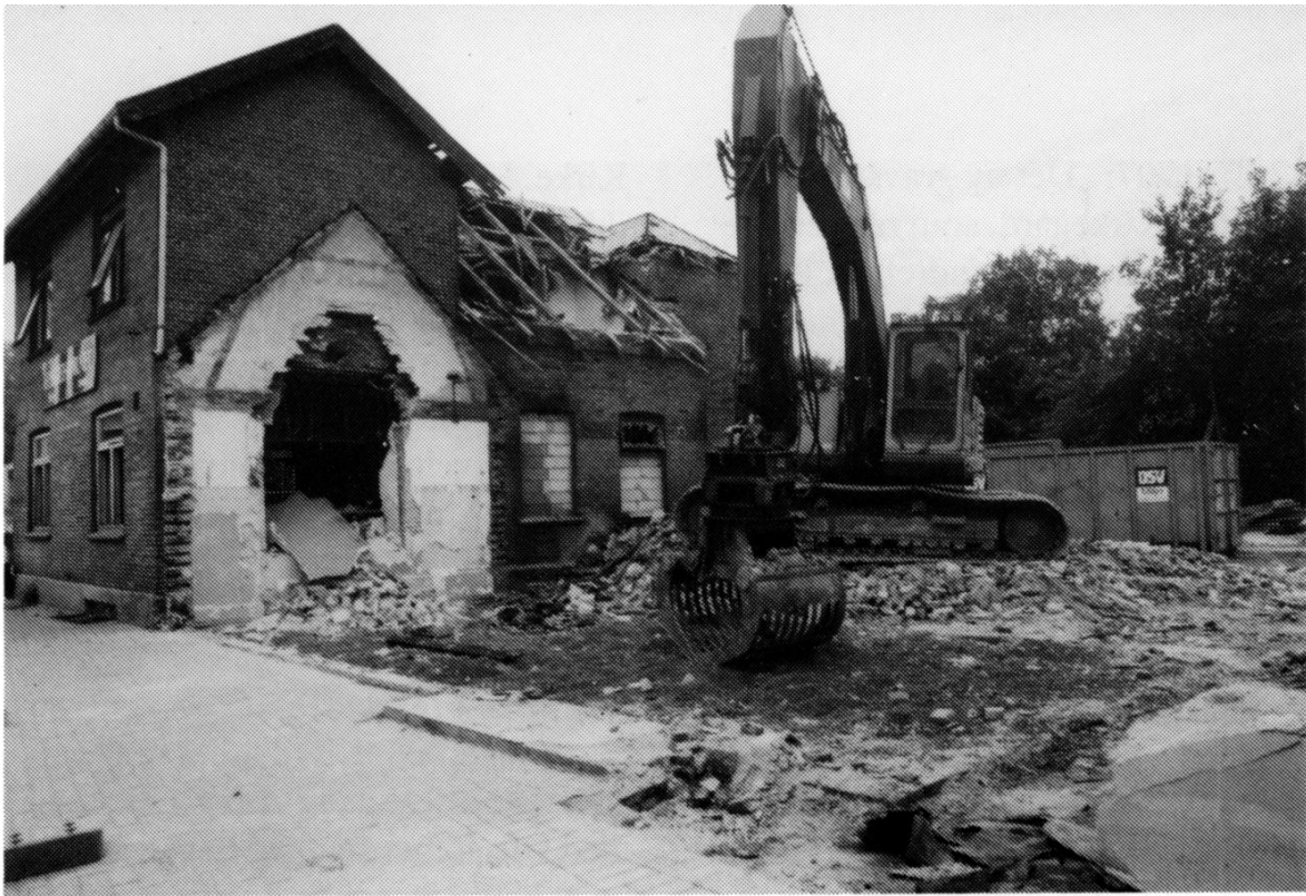
Nedrivningsbilledet fra de første augustdage viser bagerbygningens beskedne dimensioner.
