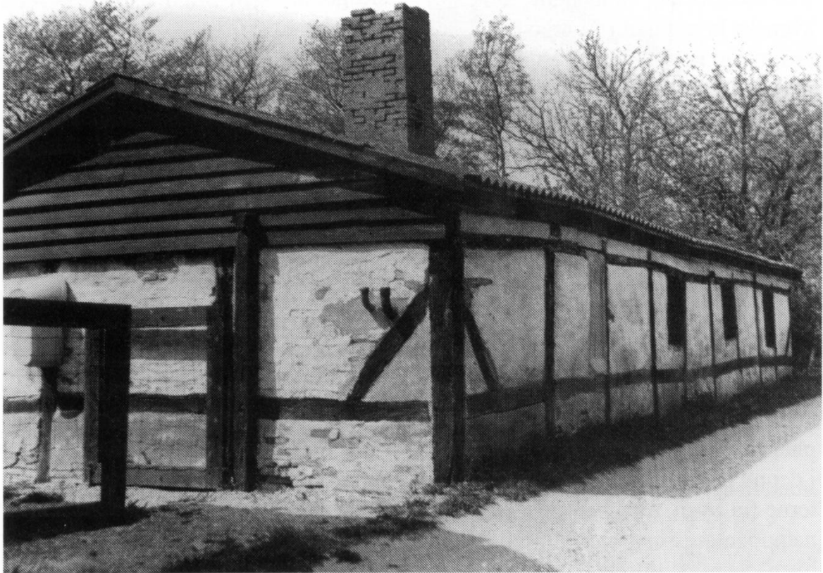
Kollerød mærkeligste hus: Den gamle skoles meget gamle udhus, der iflg. traditionen er et genopstillet bindingsværkshus fra den endnu ældre rytterskole. 1980.
