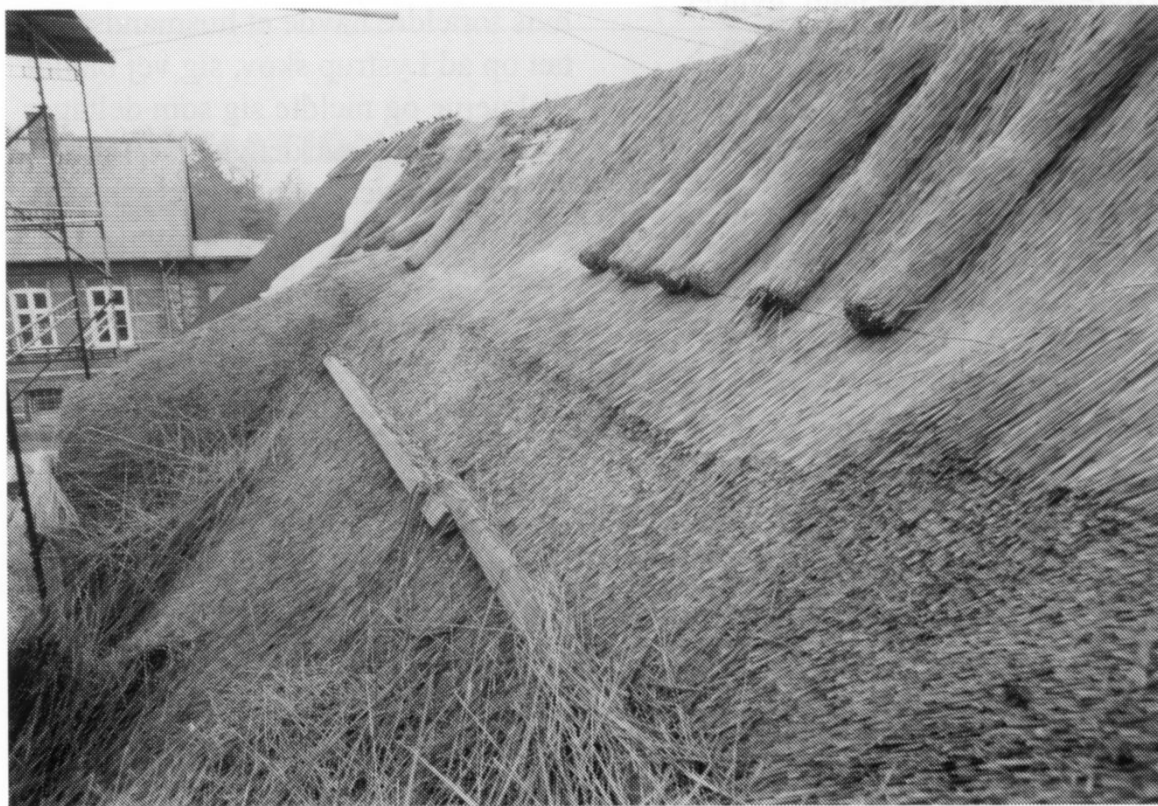
Et flot stykke tækkearbejde udført i våde, mørke dage under presenningstag i slutningen af 2006.
