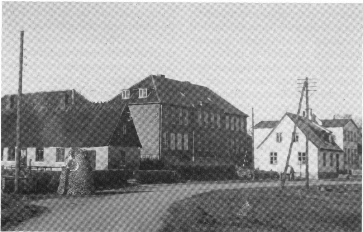
Den nybyggede skole trænger sig på. Man byggede fornuftigvis den nye færdig, før den gamle blev nedrevet.
