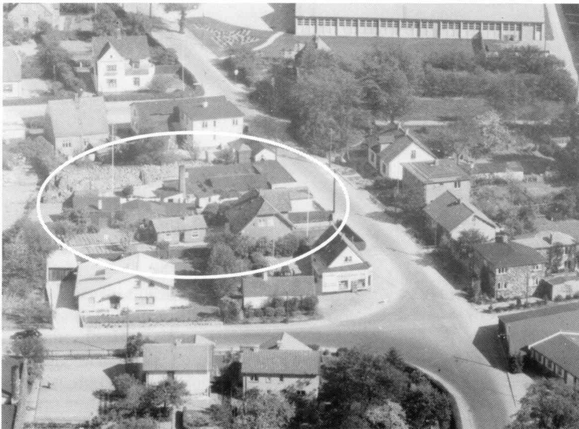
Bøjlefabrikken ses her som nabo til Allerød Mølle og dennes ucharmerende boligbygning, ca. 1956. Man ser den kantede skorsten og et enormt lager af træ. Bøgetræ til bøjler eller brændsel.
