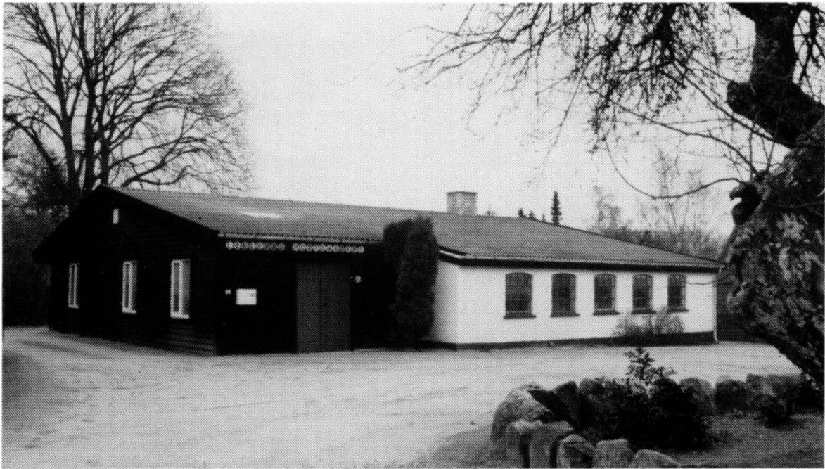
Lervarefabrikken genopstod efter branden 1953 i lagerbygningen, hvor der også var salgslokale for de lokale kunder 1995
