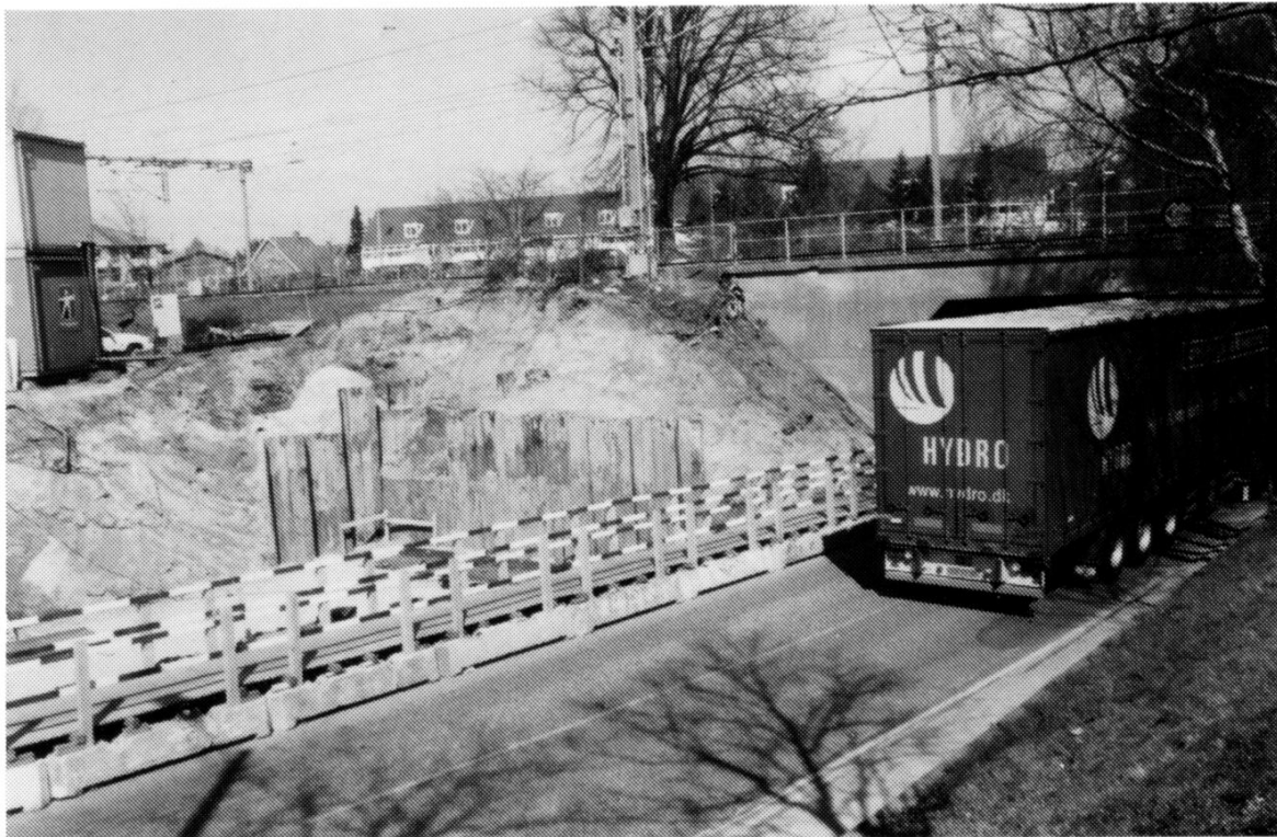
Udgravningen til den tiltrængte viaduktudvidelse, maj 2005.
