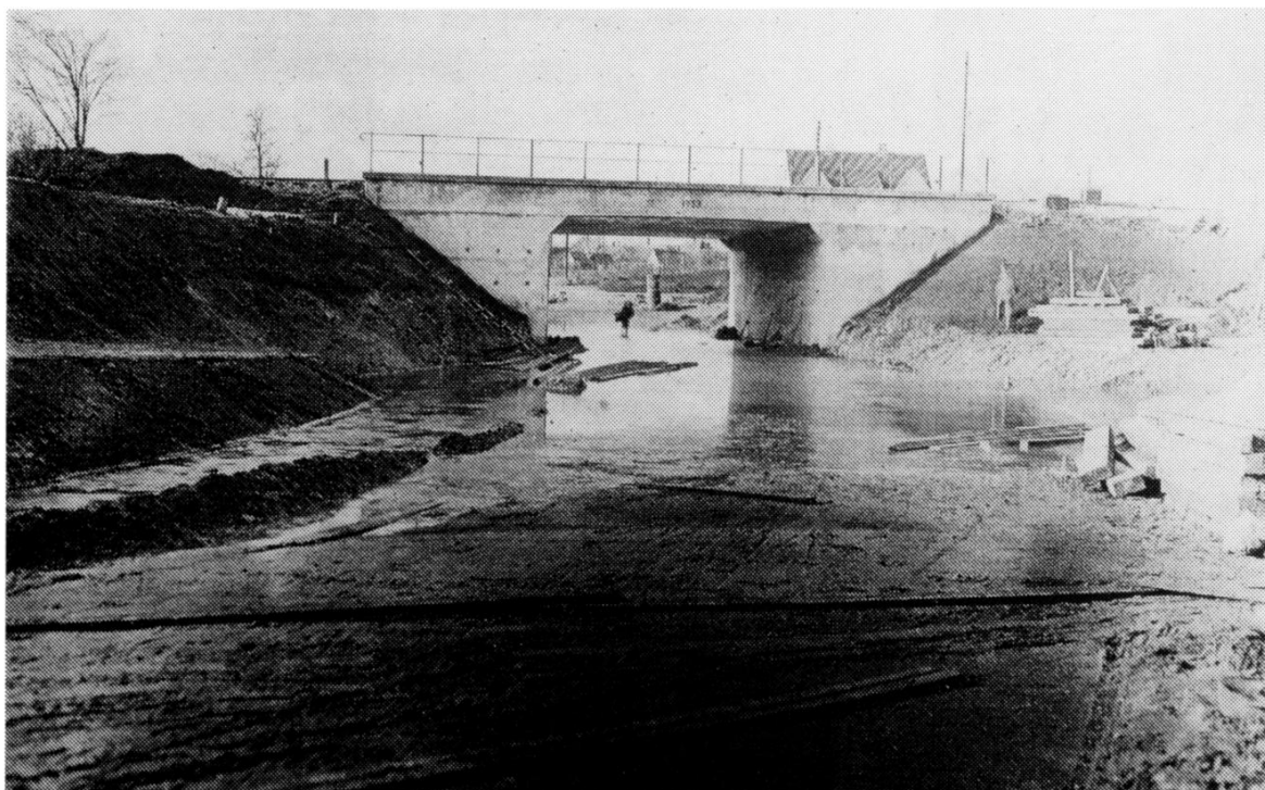
Den færdigstøbte betonbro over udgravningen, der her ses vandfyldt. Bagved knejser taget på Mølcks Konditori, nu Q8 tankstation m.v.
