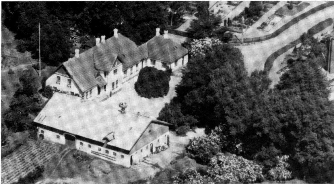
Lufbfoto fra 1946, der viser Blovstrød præstegård fra Syd. Graverkontoret er indrettet i den lille bygning øverst i billedet, laden med storkereden er nu erstattet med en ny præstebolig.
