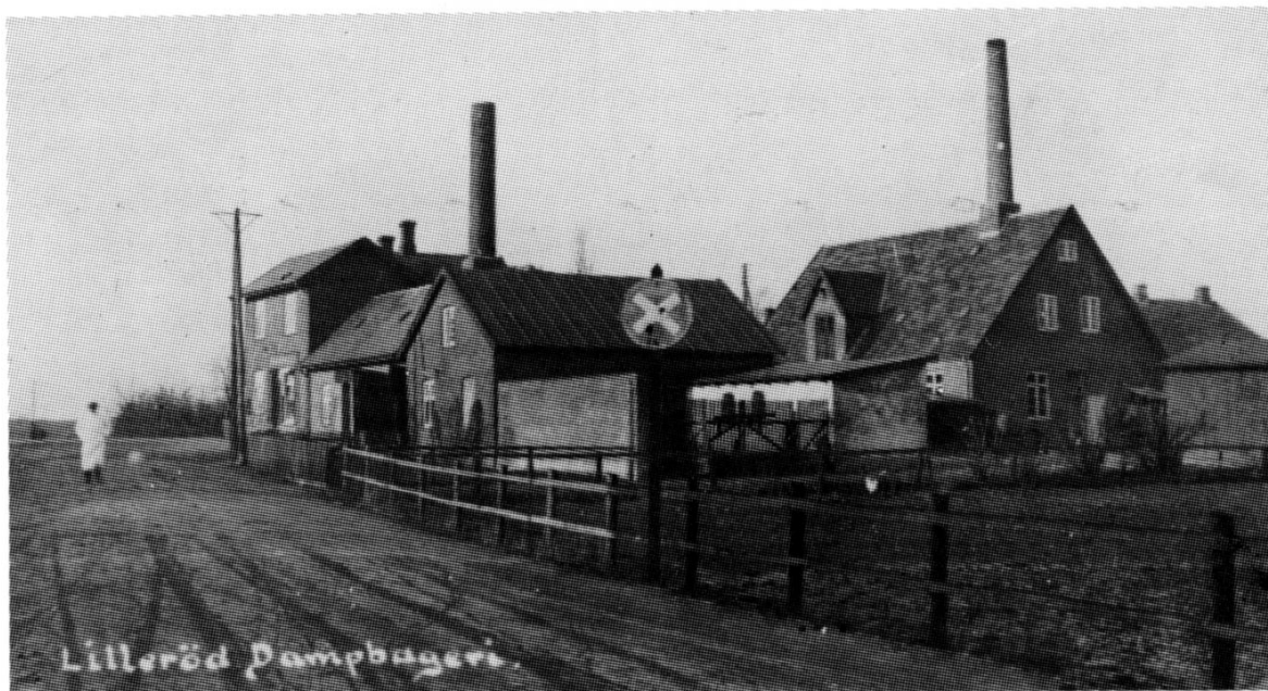
I 1920'erne opførtes en ny stor bageribygning med høj skorsten (th), mens storstenen på den lave bygning er ombygget og flyttet.
