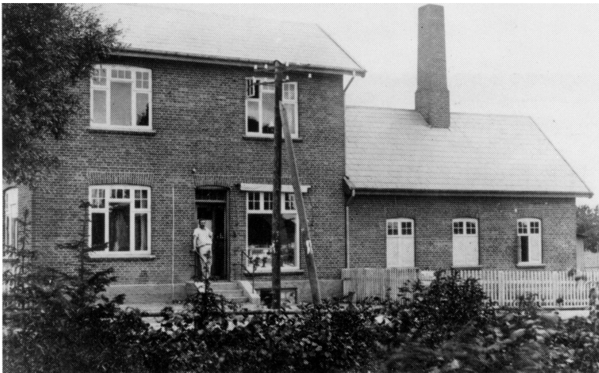
Bageribygningen havde fra starten indgang og butik i det høje hus, mens bageriet var i den lave bygning.
