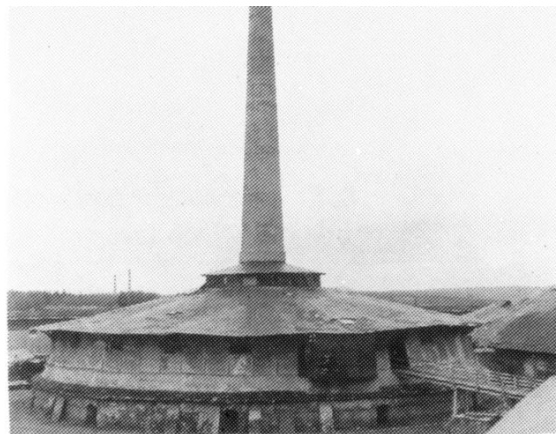
At holde en teglværksovn i gang i månedsvi- med rette brændingstemperatur, krævede sin mand - en Teglbrænder.
