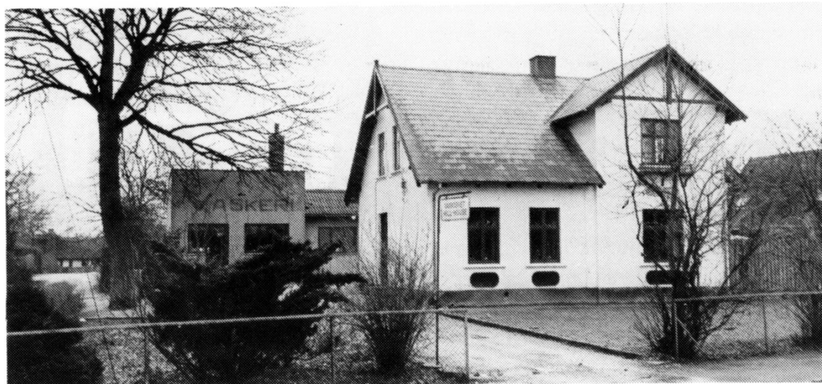
Vaskeriet Hill House (vi ved ikke hvorfor det skulle hedde sådan!) på hjørnet af Gl. Lyngvej og Wolthersvej.
