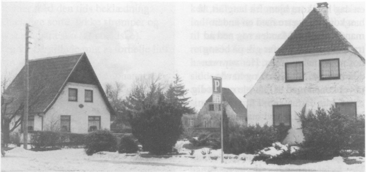
Tre af de 4 „byggeforeningshuse“ ved Frederiksborgvej efter nogen ombygning i 1981.
