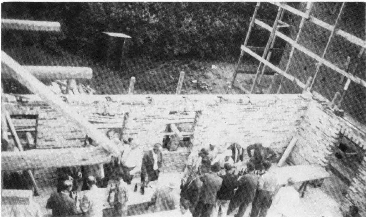
Rejsegildet 1953, dengang man byggede ordentligt med mursten og rigtige tømmerstilladser.
