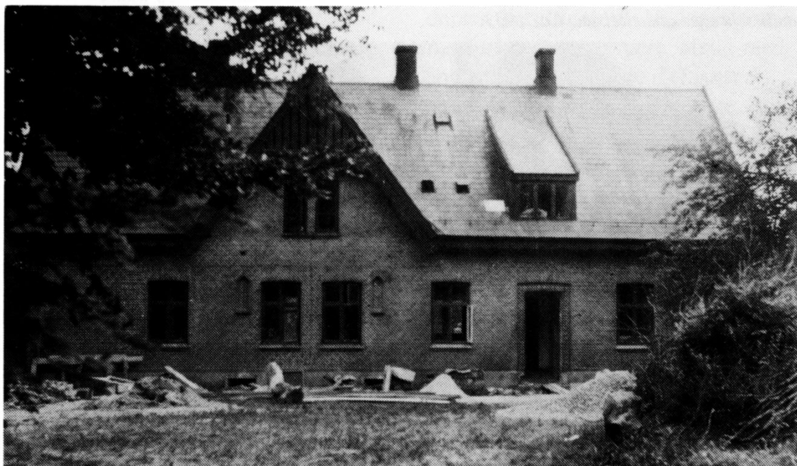
Blovstrød kommune ombygger i 1942 den tidligere skovriddergård på kongevejen til kommunekontor.
