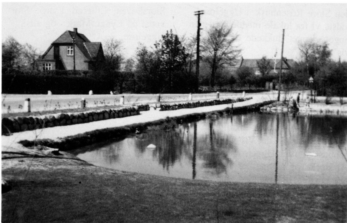
Lillerød Gadekær skiftede udseende gennem årene - fra vandhul til parkanlæg. I 1930 var bredden mod Frederiksborgvej stensat. Huset er Villa Krogh, Frederiksborgvej 57.
