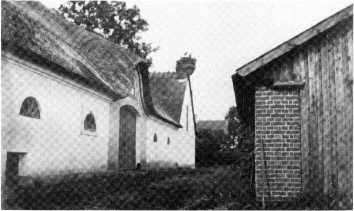
Nordlængen set mod vest med storkereden, der var beboet fra 1875 til 1950. Til højre en nu nedrevet udhusbygning. 1927.
