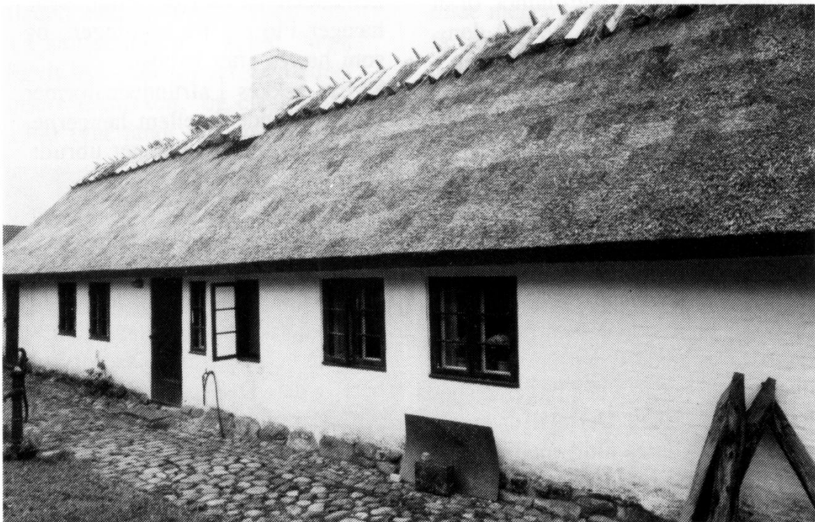
Wolthersvej 8: I et helt nytækket tag ses de enkelte rørbundters lidt forskellige farver den første tid. Siden får taget en jævn grålig farve. Foto: Ole Høegh Post.
