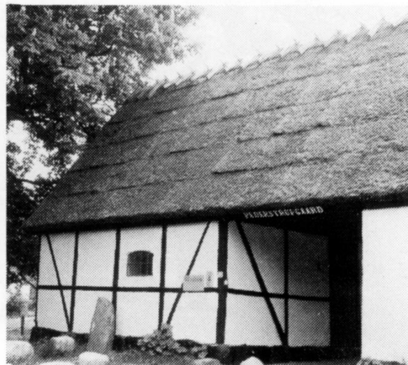
En rigtig dårlig ide: Stråtagselementer ældes grimt, og samlingerne ses tydeligt, så taget bliver ternet. Foto: Ole Høegh Post.
