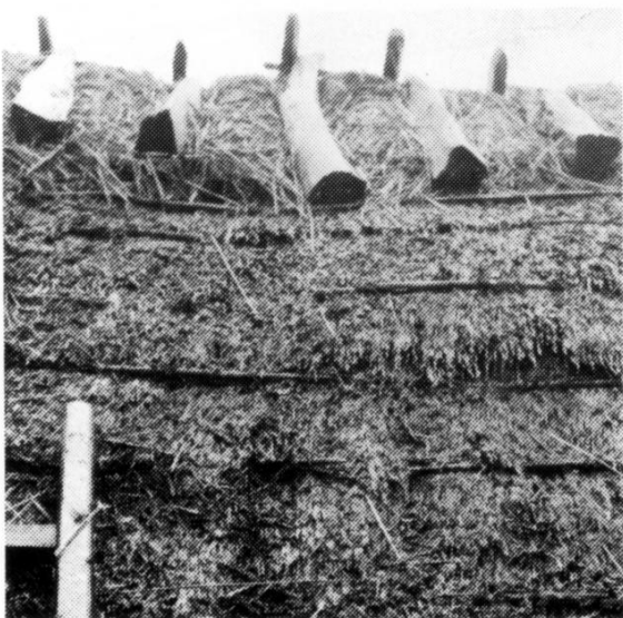
Gammelt tyndslidt tag med synlige tækkæppe. Foto: Ole Høegh Post. 1976
