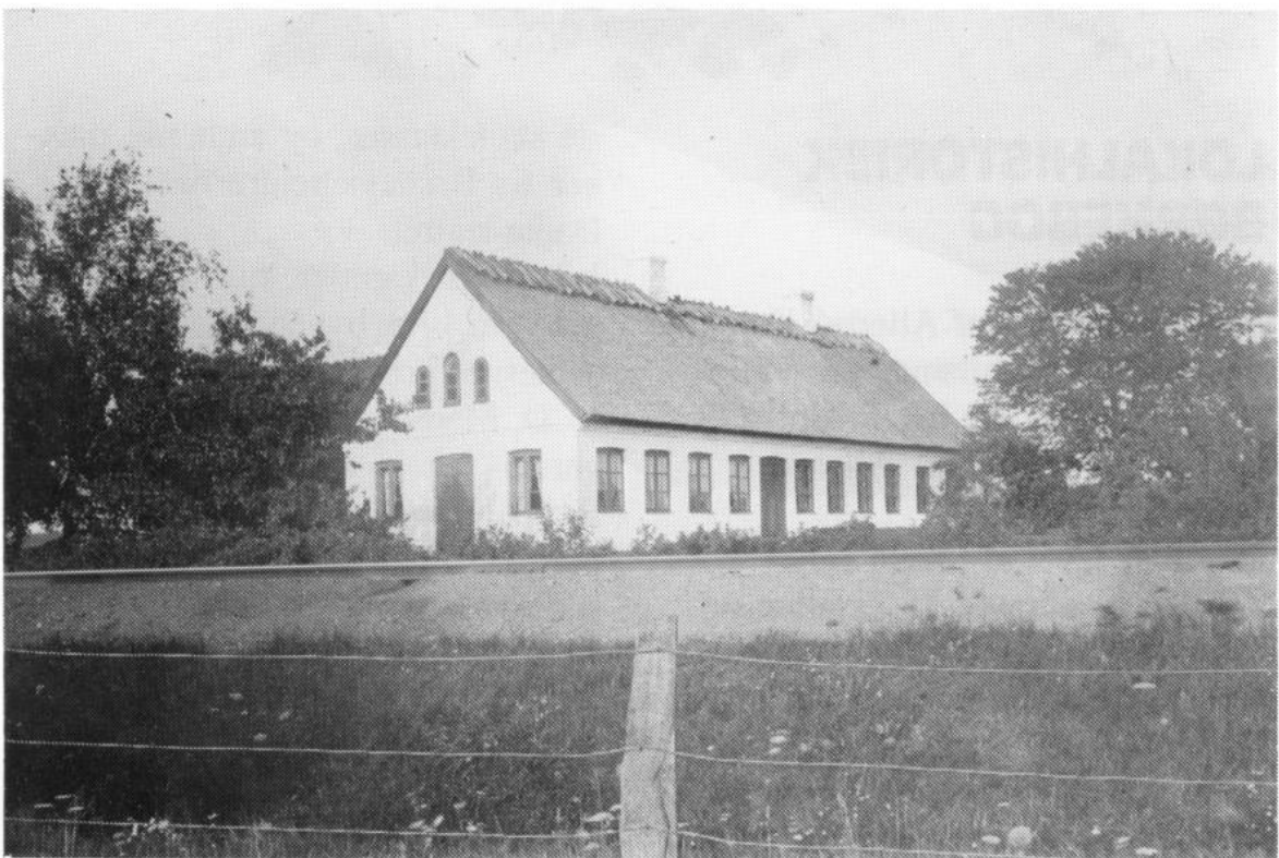
Det nylig nedrevne husmandssted "Nøjsomhed" set tværs hen over jernbanesporet. Da DSB anlagde dobbeltsporet i 1933, forlangte man det brandfarlige stråtag dækket af blikplader.
