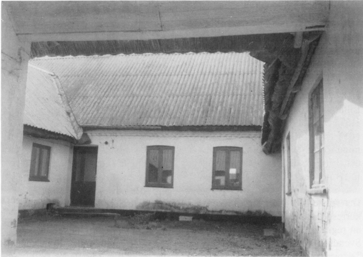
Et kig ind gennem Nøjsomheds port mod stuehuset, der var kraftigt ombygget. UH 1995.
