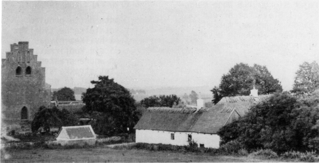
Blovstrød Præstegård, fotograferet før 1897, hvor den brændte. Det er tænkeligt, at billedet viser de samme bygninger, som Junge levede i.
